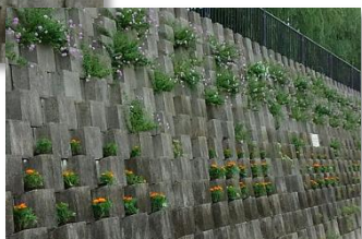
花植え作業後の護岸堤
